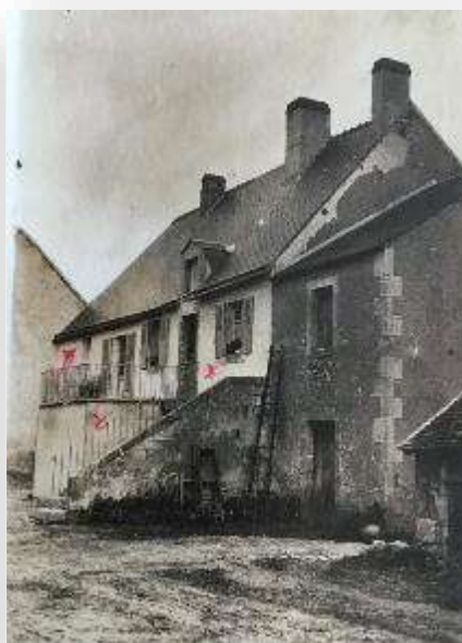
2 Allée du Broutet
