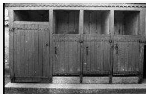
Les w.c. de la cour des garçons
