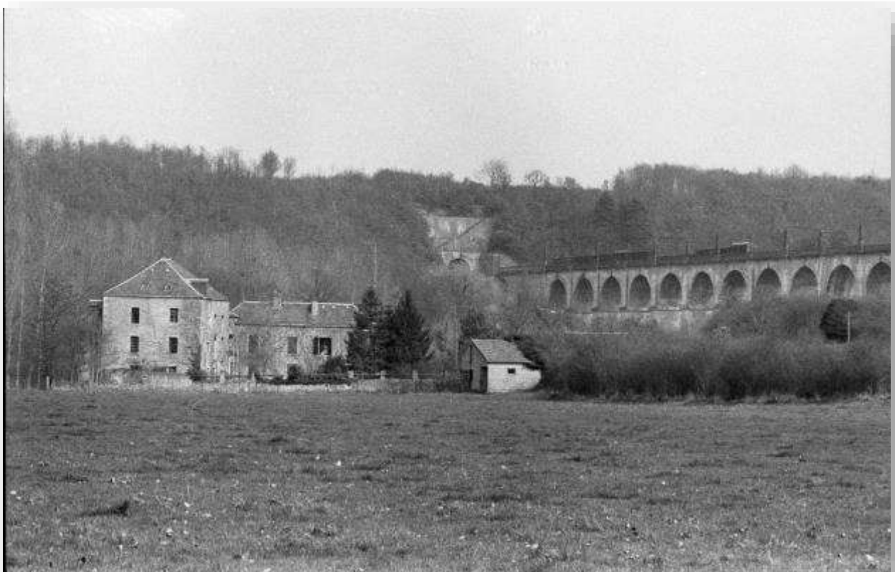
Le moulin du Boutet le tunnel et le viaduc (Photos Marion Kalter)
