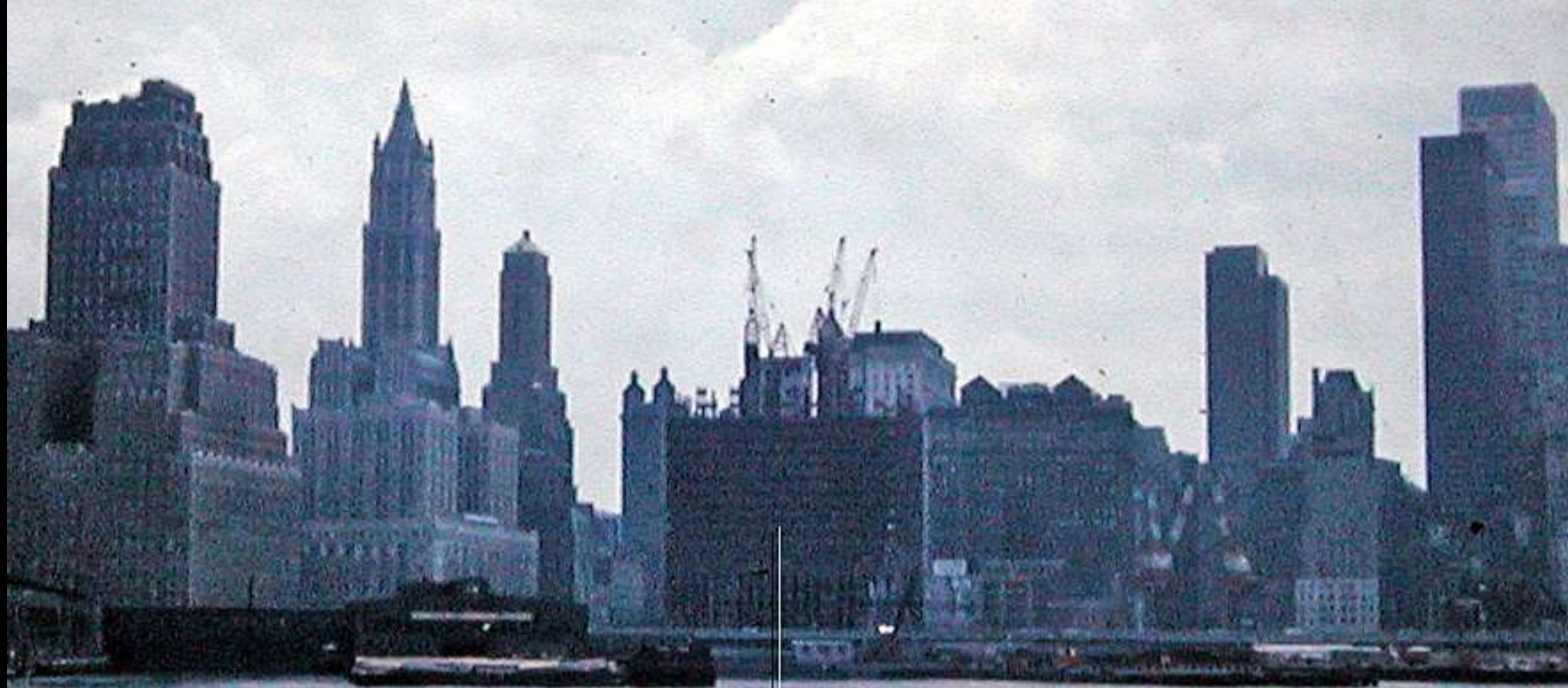
World Trade Center en construction
