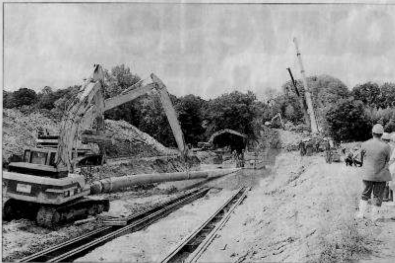
Opération spectaculaire hier, au Pont-Chrézien pour la dépose du gazoduc dans le lit de la Creuse.
