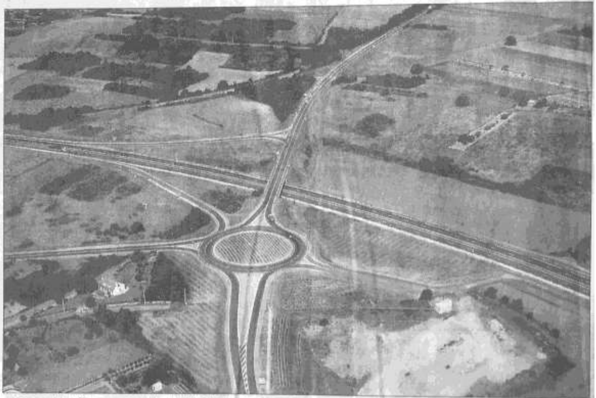
L'accès nord de l'Occitane est à 7 km du Pont-Chrétien. La réalisation d'une sortie au rond-point de Saint-Marcel réduirait la distance à 1,5 km. Cet accès vers Châteauroux est déjà matérialisé (à droite sur notre photo).
