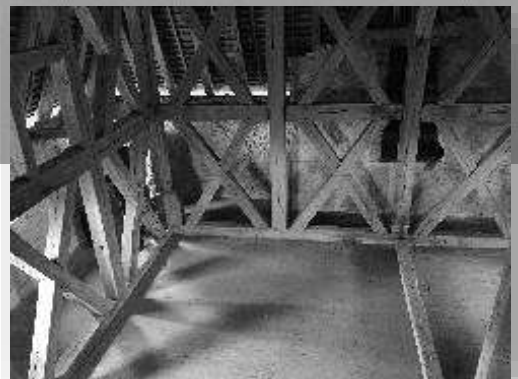
Une partie de la charpente du donjon
