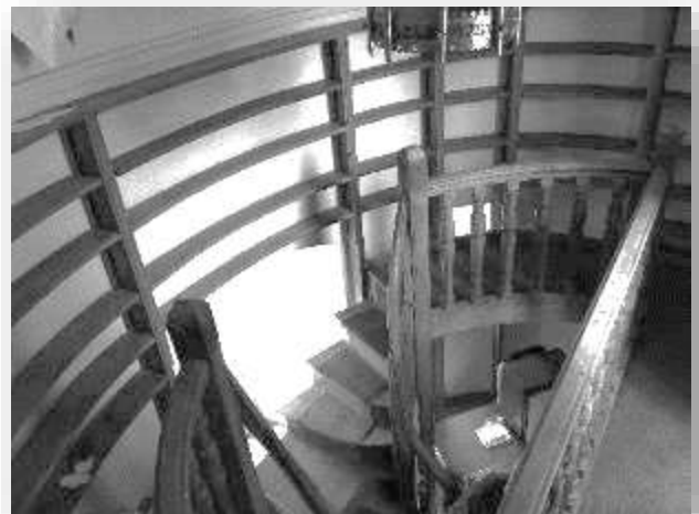
La bibliothèque du château de Chabenet après restauration
