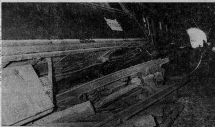
Le tunnel après le déraillement. On juge de la pression qui a été exercée sur les rails les traverses.
