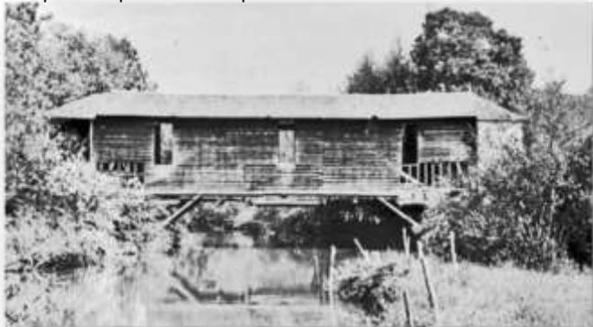
Le Pont de Bois avant restauration
