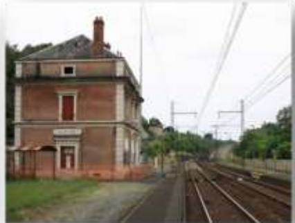
La gare de Chabenet avant démolition (photo A. Gautier)
