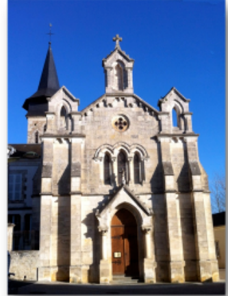
Façade ouest de l'église du Pont- Chrétien (photo A.Gautier)
