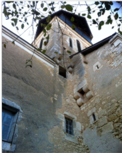
Bretèches protégeant la porte d'accès à l'escalier fin XV ème début XVIe (photo A.Gautier)
